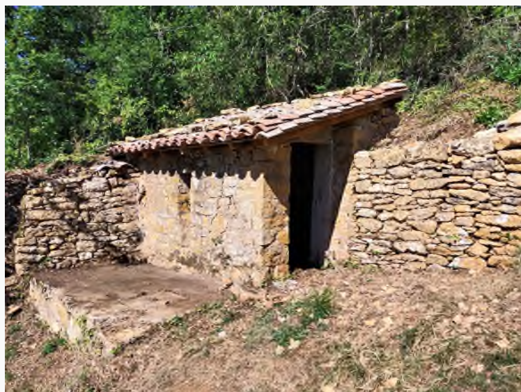
cabane vigne sous les carrières après restauration
